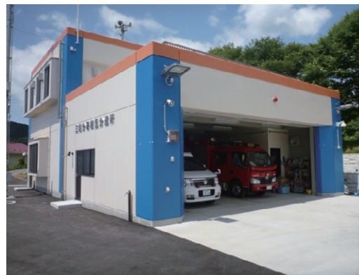
【消防庁舎復旧事業】 大船渡地区消防組合大船渡消防署 三陸分署綾里分遣所
