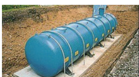
【耐震性貯水槽】
